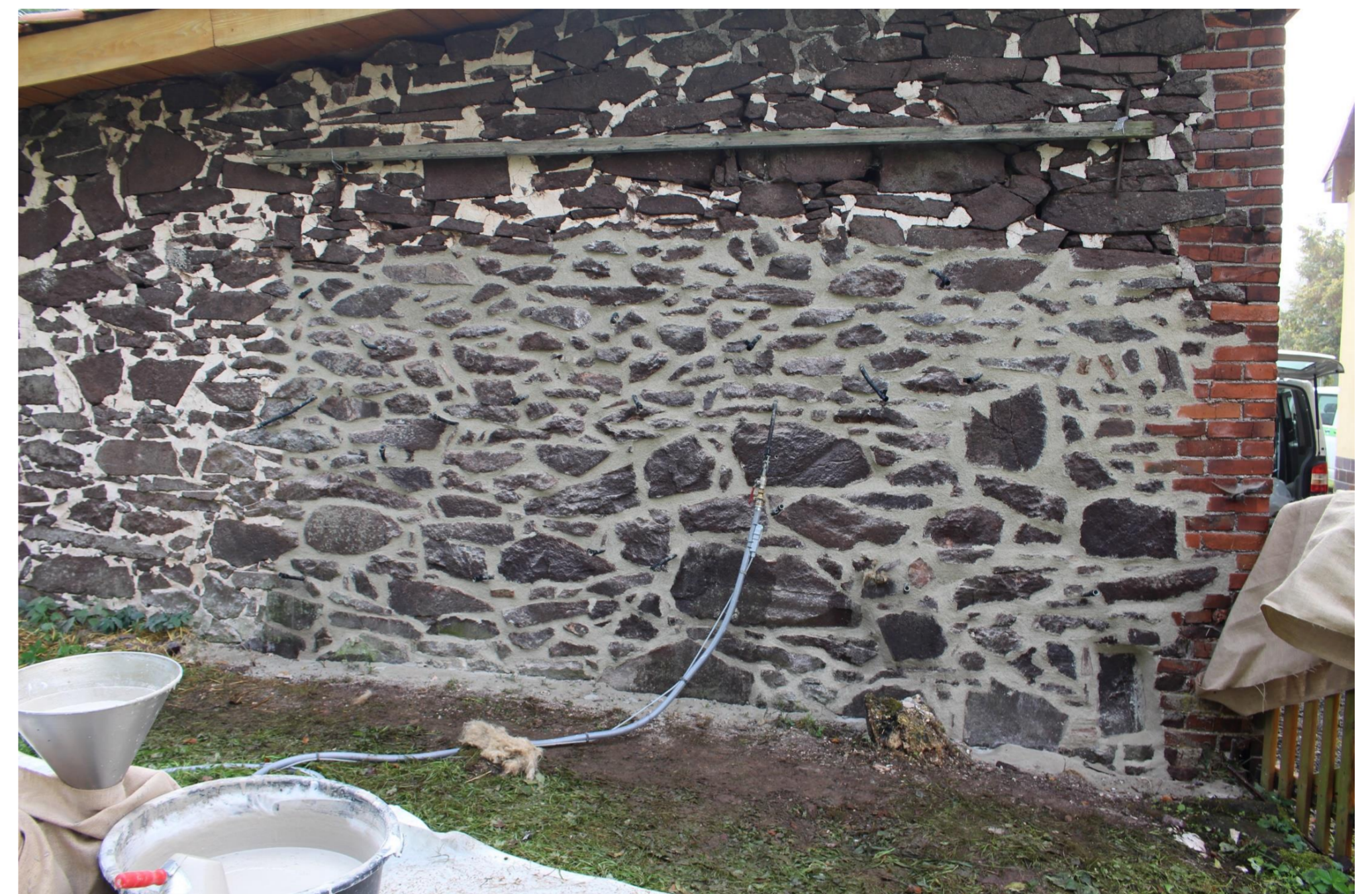
Bild 2: Sanierung gipshaltigen Mauerwerks mit Injektionsschaummörtel und Fugenmörtel auf der Basis des patentierten Bindemittels
