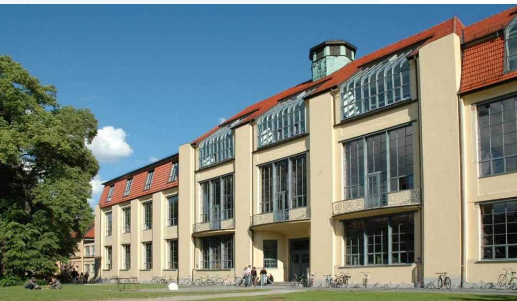
Hauptgebäude der Bauhaus-Universität Weimar
