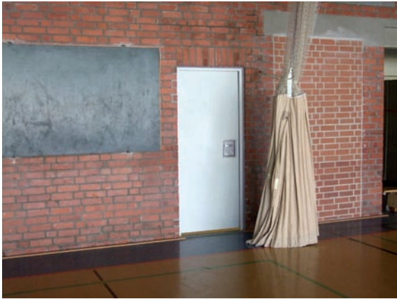
Öffnungen zum 1. Obergeschoss durch Mauerwerk rauchdicht verschlossen
