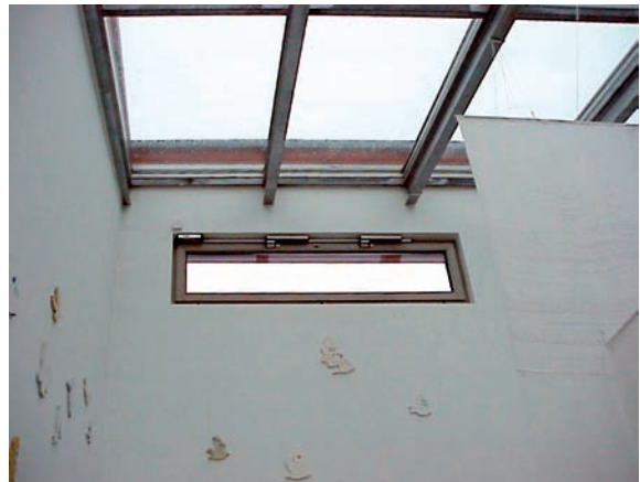
Rauch- und Wärmeabzug?
