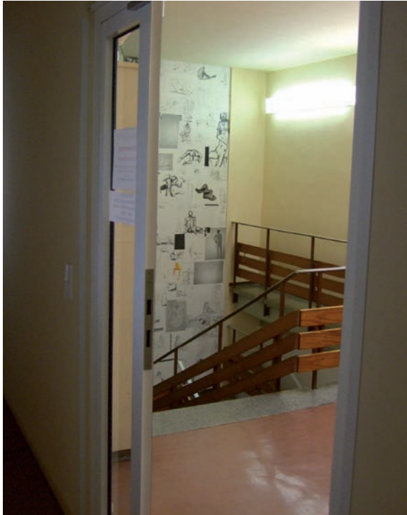
1. Obergeschoss – Innenliegender, abgeschotteter Treppenraum
