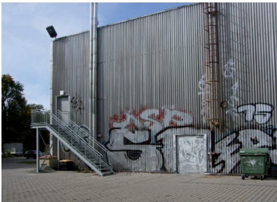
Sporthalle Südfassade mit Fluchttreppe
