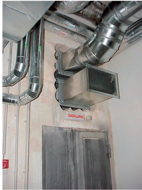
Nichtverschlossener Wanddurchbruch
